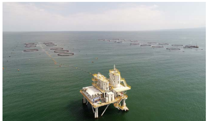
大規模沖合養殖を可能とするプラットフォーム型自動給餌システム（サーモン養殖） 弓ヶ浜水産株式会社 境港漁場（鳥取県境港市）
