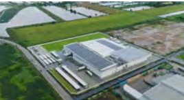
太陽光発電設備(タイデルマール社)
