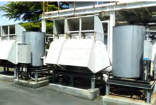
チラー（冷却水循環装置）
