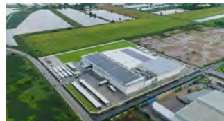
太陽光発電設備（タイデルマール社）
