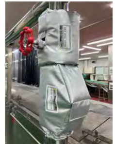
断熱ジャケットによる断熱性向上
